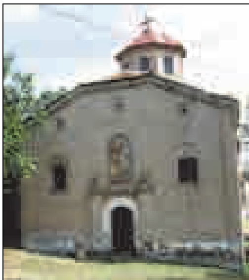
Западна фасада West facade
