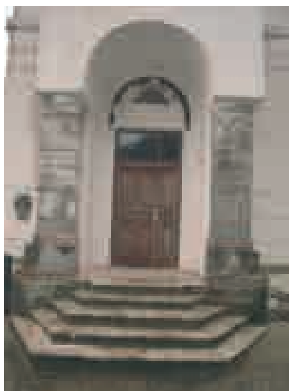
Влезна партија, западна фасада Entrance, west facade
