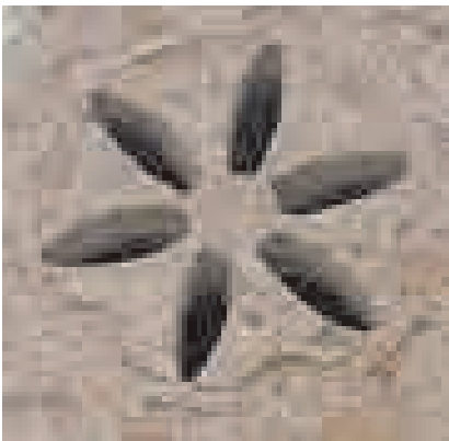
Транзена, западна фасада Transom, west facade
