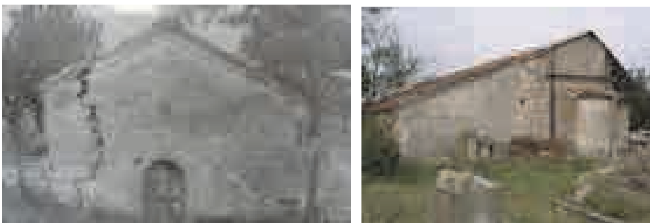
Св. Спас во Довезенце, западна (лево) и источна фасада (десно), XVI/XVII век St. Saviour, west fasade (left) and east fasade (right), XVI/XVII century
