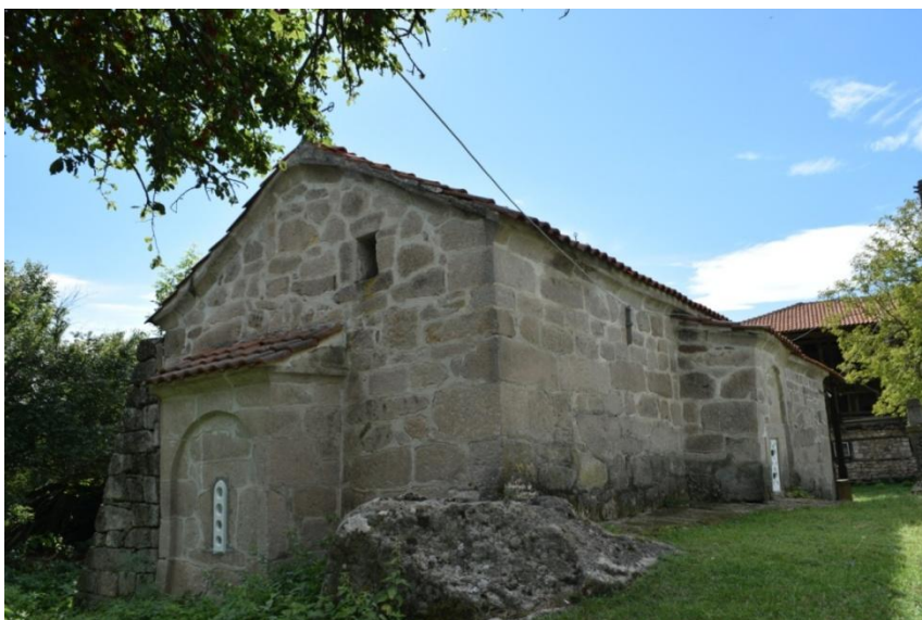
Правоаголна апсида на исток и правоаголна конха на северна фасада
